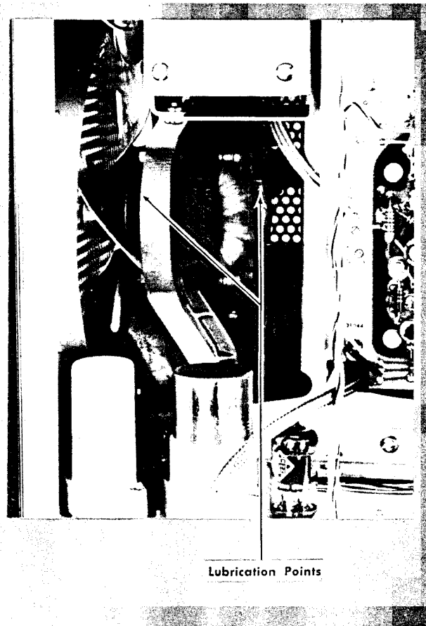
Fig. 4-1. Fan motor lubrication points.
